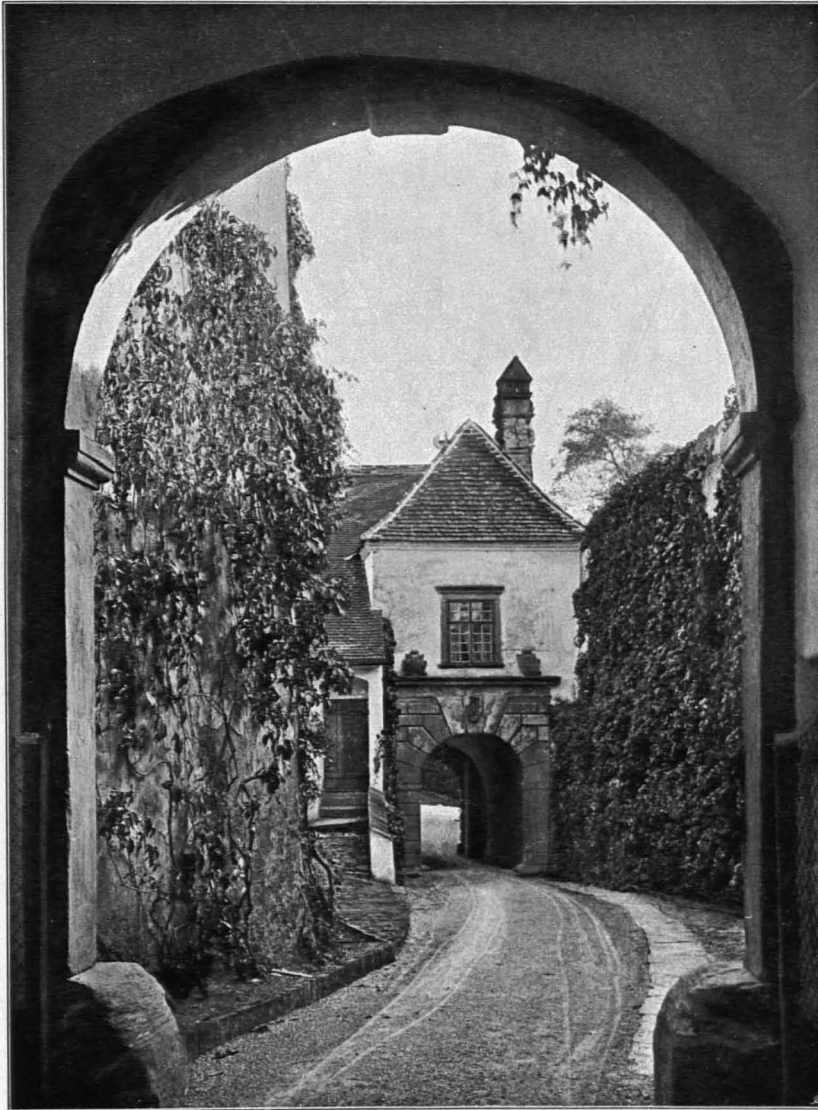
Fig. 23 Schallaburg, Vorhof und Torbau von Norden (S. 16)
