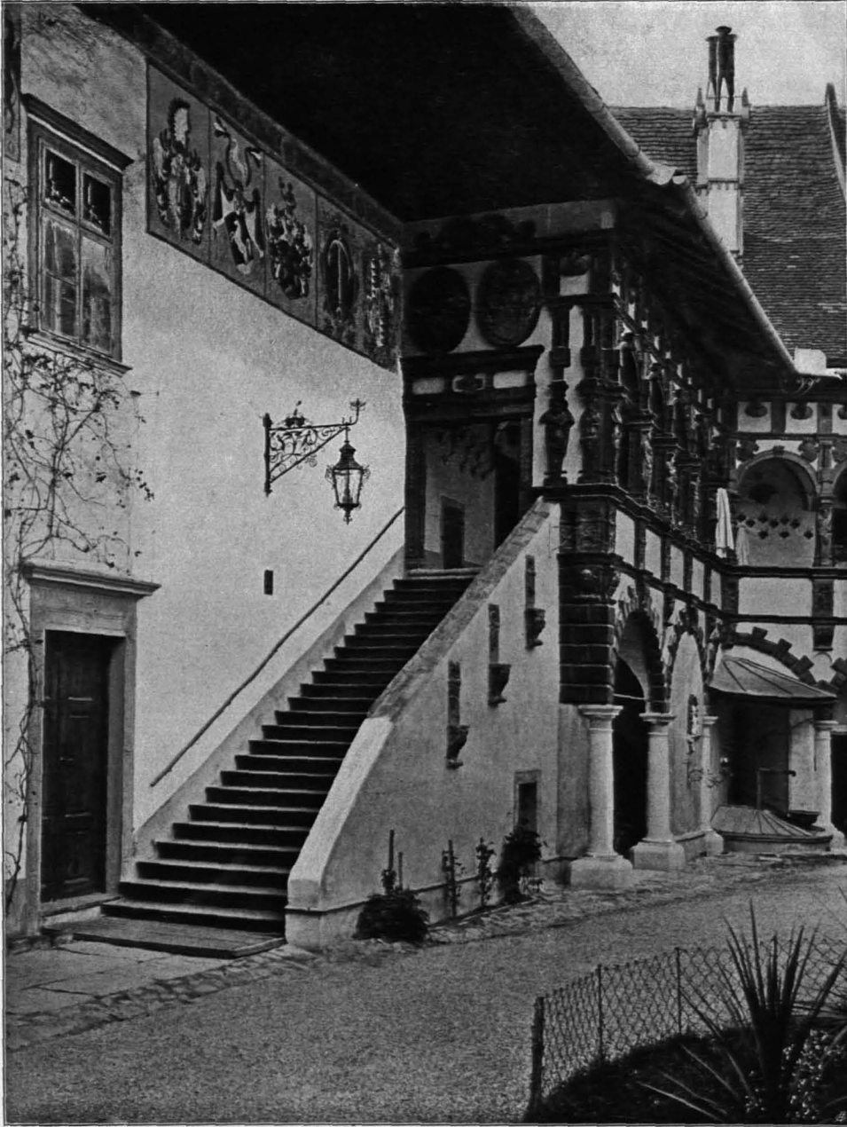
Fig. 42 Schallaburg, Stiegenaufgang im Nordwesten (S. 25)
