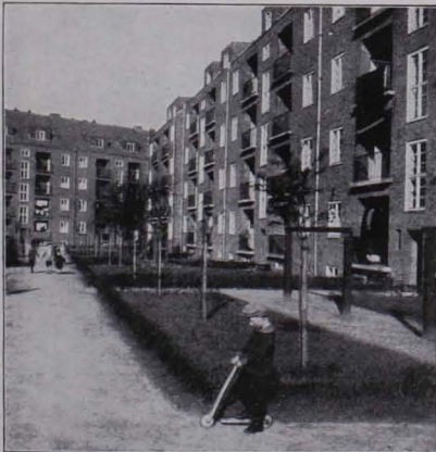
Abb. 141 STÄDT. BAUBLOCK, ALTONA, SCHÜTZENSTRASSE, 1926
