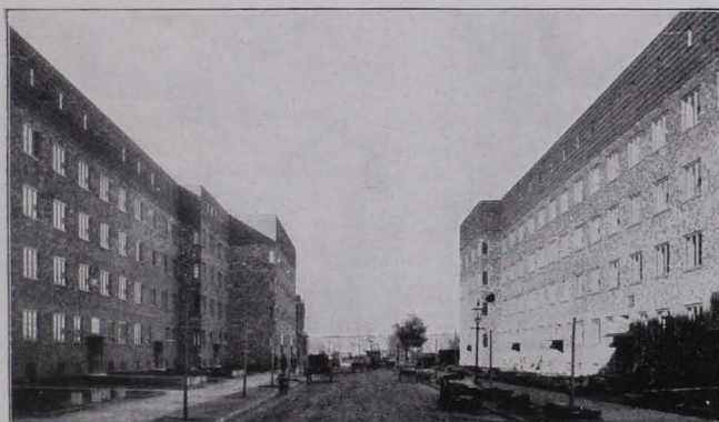
Abb. 139 STÄDT. BAUBLOCK, ALTONA, HELMHOLTZSTRASSE, 1926.
