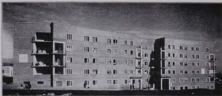
Abb. 138 WOHNHAUS DER GEMEINDE WIEN XVII 1924, SÜDSEITE
