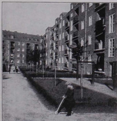
Abb. 141 STÄDT. BAUBLOCK, ALTONA, SCHÜTZENSTRASSE, 1926
