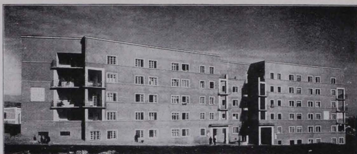
Abb. 138 WOHNHAUS DER GEMEINDE WIEN XVII 1924, SÜDSEITE
