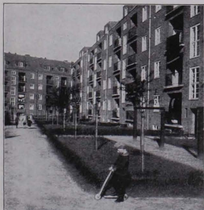
Abb. 141 STÄDT. BAUBLOCK, ALTONA, SCHÜTZENSTRASSE, 1926
