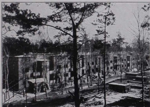
Abb. 117 SIEDLUNG DER GEHAG IN ZEHLENDORF BEI BERLIN, 1926/27, im Bau
