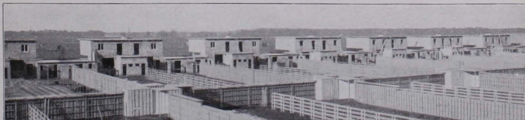
Abb. 120 SIEDLUNG DESSAU-ZIEBIGK, 1926/27, IM BAU
