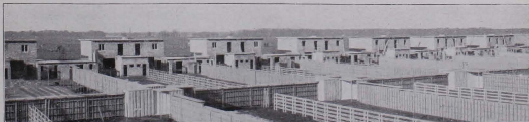
Abb. 120 SIEDLUNG DESSAU-ZIEBIGK, 1926/27, IM BAU
