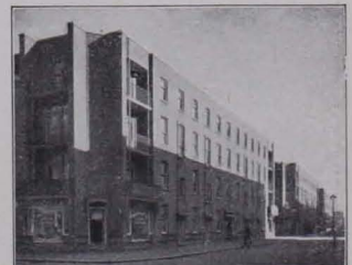
Abb. 95 TUSCHENDYKEN, 1920, GYSINGSTRAAT, ROTTERDAM
