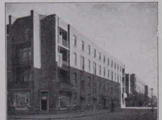
Abb. 95 TUSCHENDYKEN, 1920, GYSINGSTRAAT, ROTTERDAM
