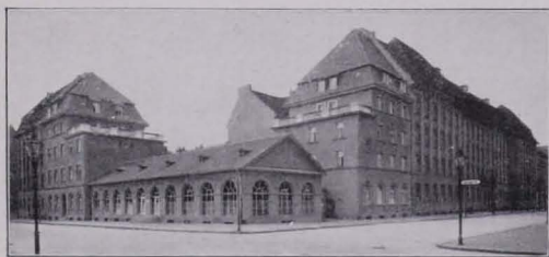
Abb. 32 Alfa-Werke mit Wohnungen am Schillerpark in Berlin N. angebaut an Schulen von L. Hoffmann. Verunstaltung durch „Anpassung“: verkrüppelte Mansardendächer; das durchgezo- gene Gurtgesims und die gleiche Quaderung sollen „Anpassung“ sein. Vorn keine Reitbahn von 1700, sondern eine — Industriehalle von 1925. Tötung des Hoffmannbaus durch Charakterlosig- keit.
