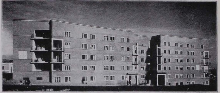
Abb. 138 WOHNHAUS DER GEMEINDE WIEN XVII 1924, SÜDSEITE
