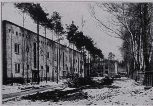
Abb. 118 SIEDLUNG DER GEHAG IN ZEHLENDORF BEI BERLIN, 1926/27, im Bau, vgl. Abb. 166
