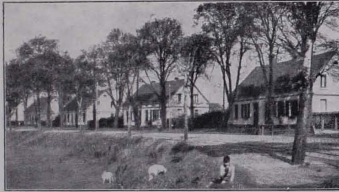
Abb. 48 SIEDLUNGSHÄUSER IN OSTERFELD, Kruppsiedlung aus den 80 — 90er Jahren, noch gesundes Bauen.
