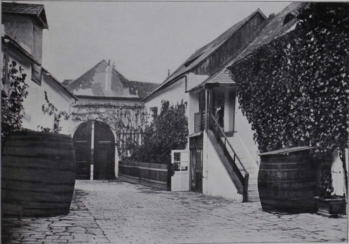
Fig. 519 Heiligenstadt, Hof des Hauses Pfarrplatz Nr. 2 (S. 413)
