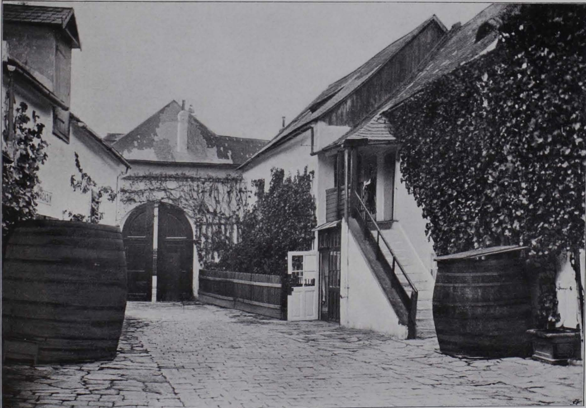
Fig. 519 Heiligenstadt, Hof des Hauses Pfarrplatz Nr. 2 (S. 413)
