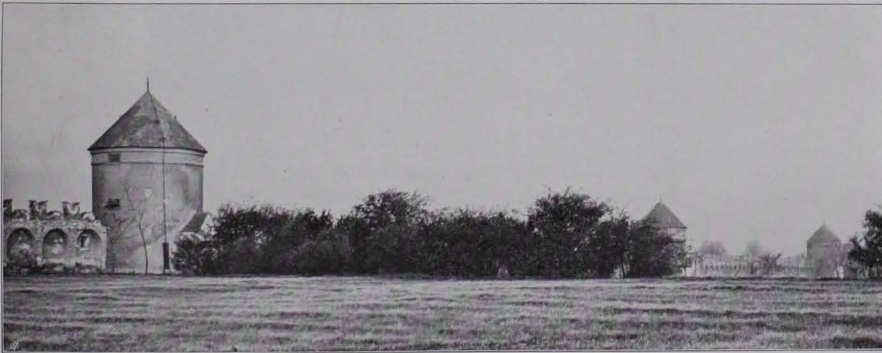
Fig. 27 Neugebäude, westliche Umfassungsmauer (S. 24)
