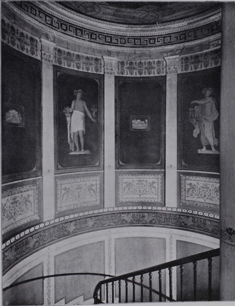
Fig. 467 Döbling, Stiegenhaus des Hauses Döblinger Hauptstraße 96 (S. 375)
