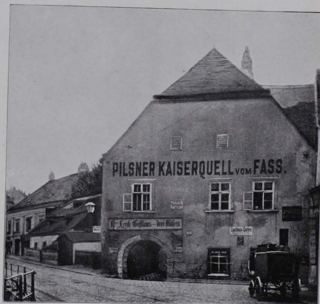
Fig. 566 Hackhofergasse Nr. 1 (S. 450)
