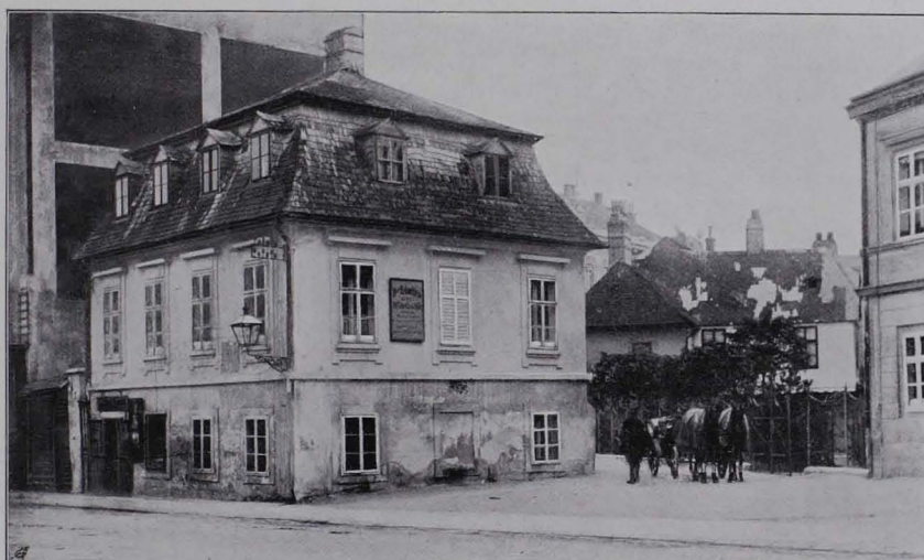
Fig. 75 Hietzing, Lainzerstraße Nr. 21 (S. 71)
