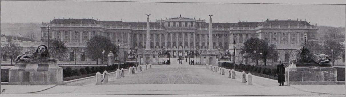
Fig. 126 Schönbrunn, Fassade gegen den Hof (S. 111)
