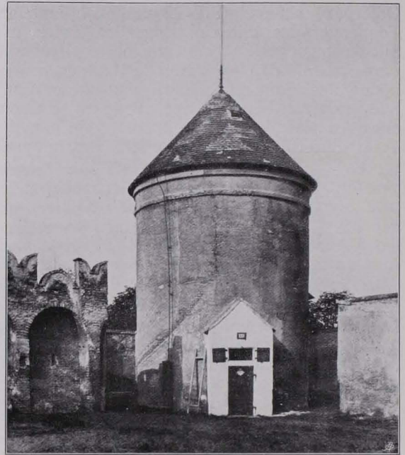
Fig. 28 Neugebäude, Mauerturm (S. 24)
