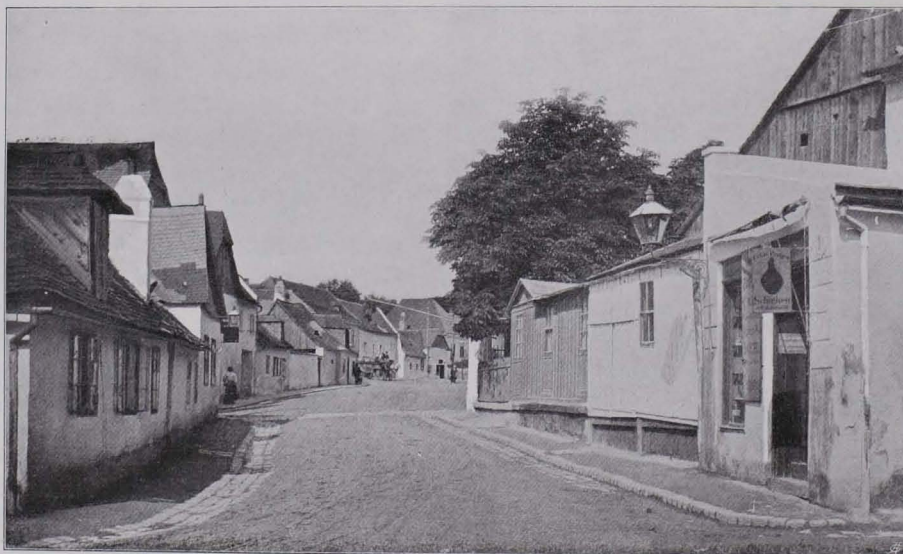
Fig. 11 Simmering, Kopalgasse (S. 10)
