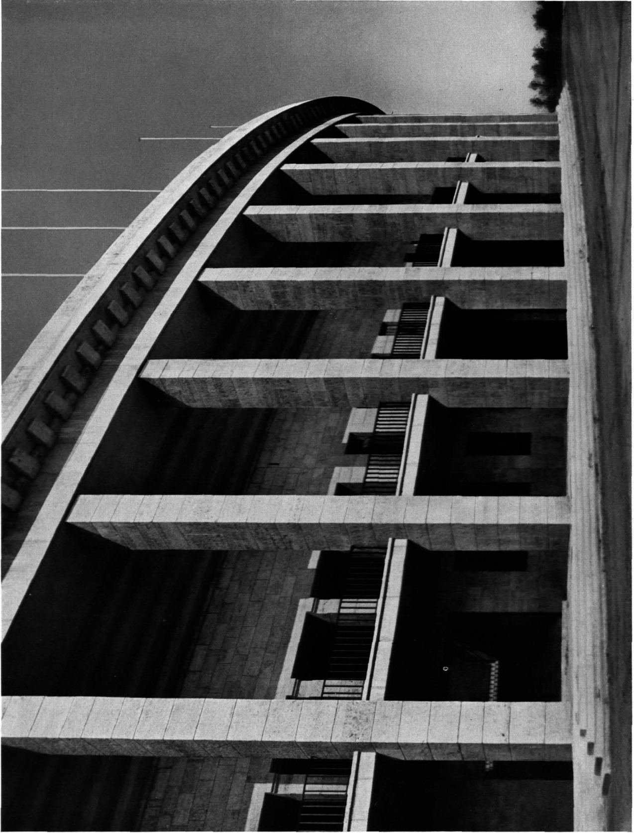
8. Olympiastadion, äußere Pfeilerwand
