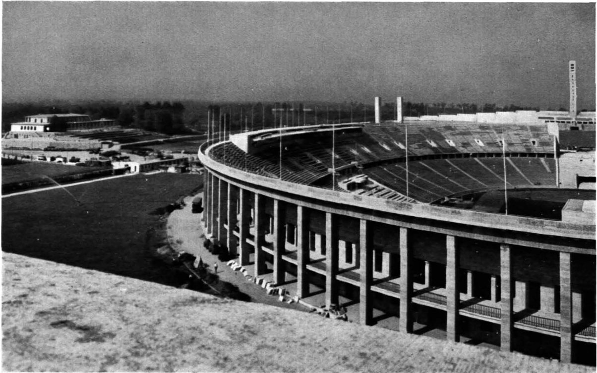
Abb. 9—10 Olympiastadion Südhälfte mit Gaststätte
