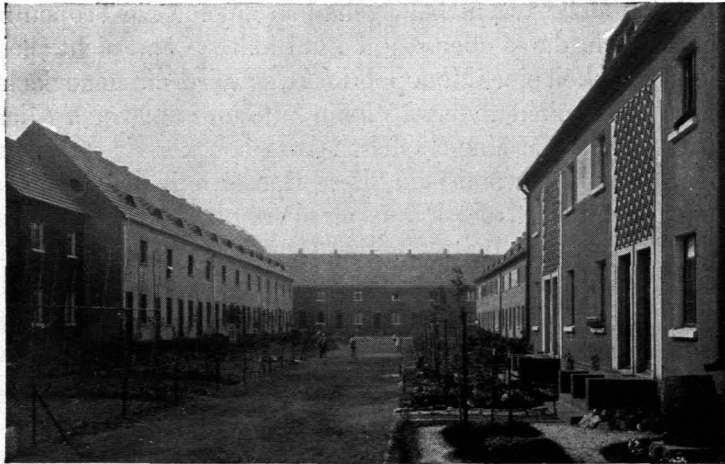
Abb. 65. Siedlung Reform Magdeburg, Privatstraße
