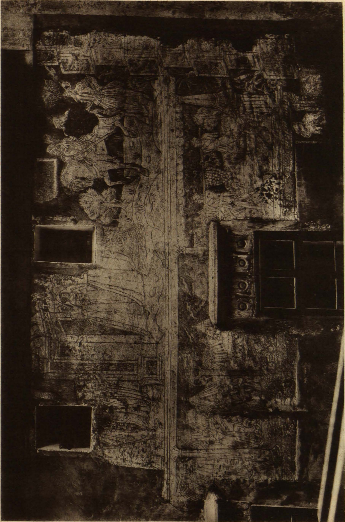
TAFEL XIII KREMS, GEMALTE FASSADE DES HAUSES ALTHANGASSE 2 (S. 264)
