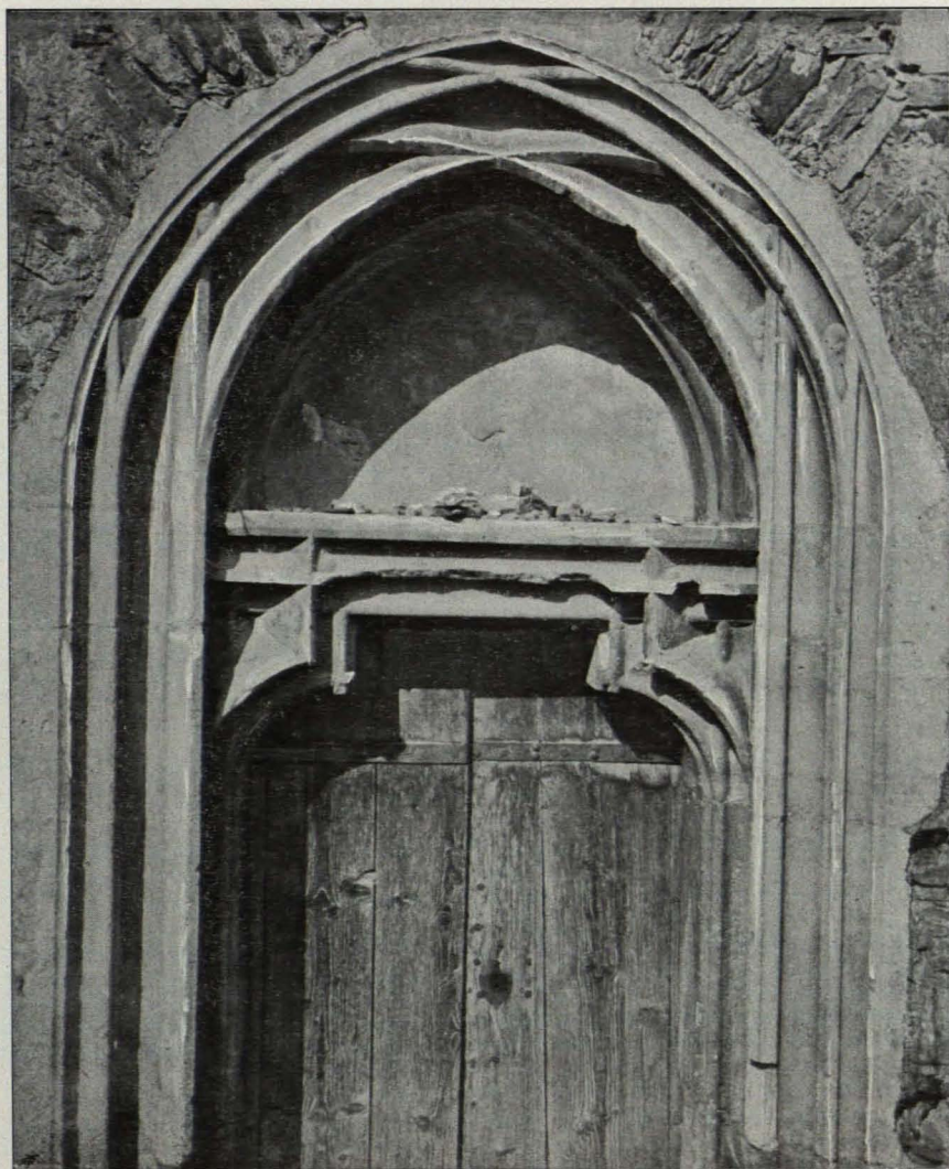
Fig. 470 St. Michael, Kirche, Westportal (S. 566)
