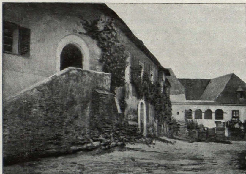
Fig. 467 Weissenkirchen, Haus Nr. 56, im Hintergrund Haus Nr. 54 (S. 561)
