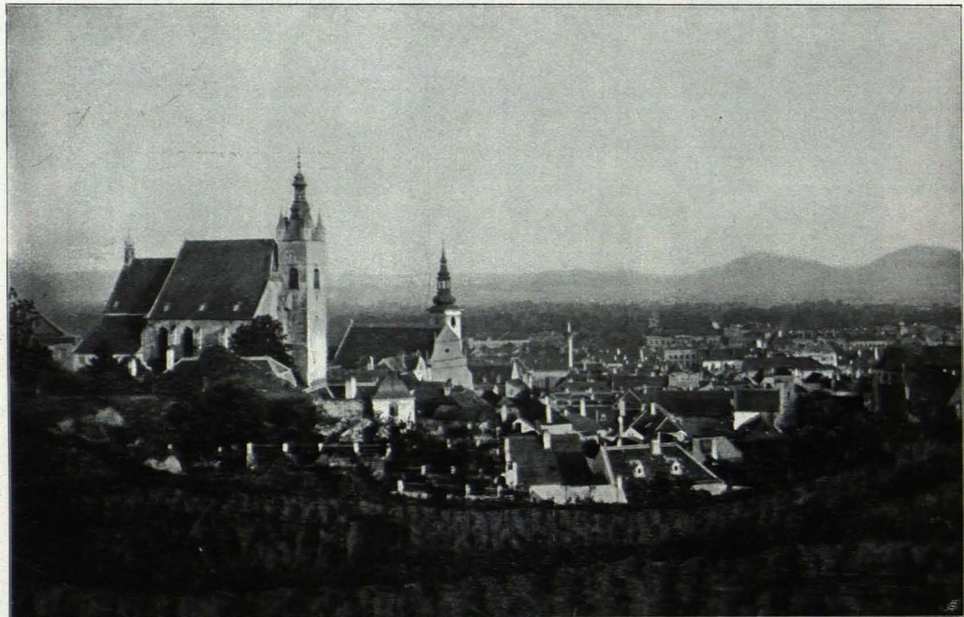
Fig. 119 Krems, Gesamtansicht von Norden (S. 203)
