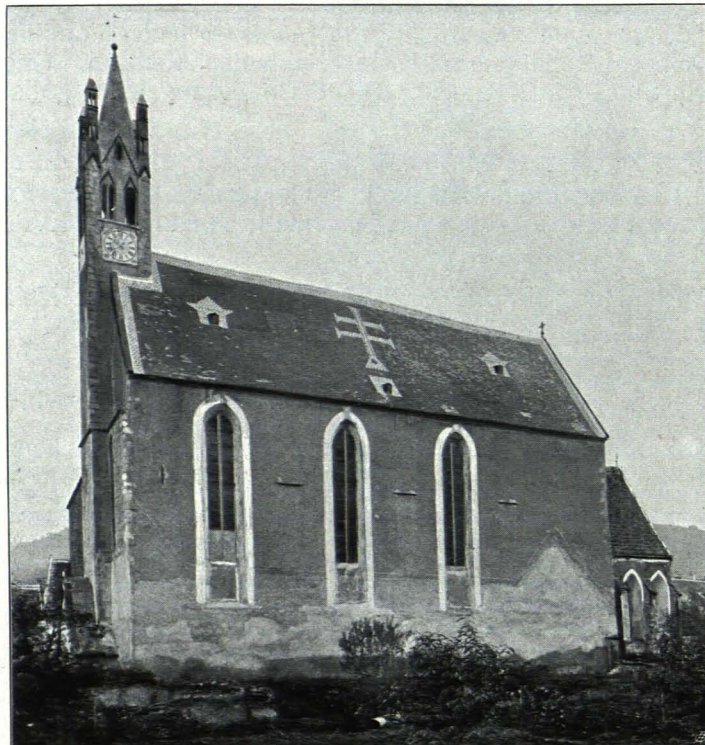
Fig. 101 Imbach, Pfarrkirche (S. 185)
