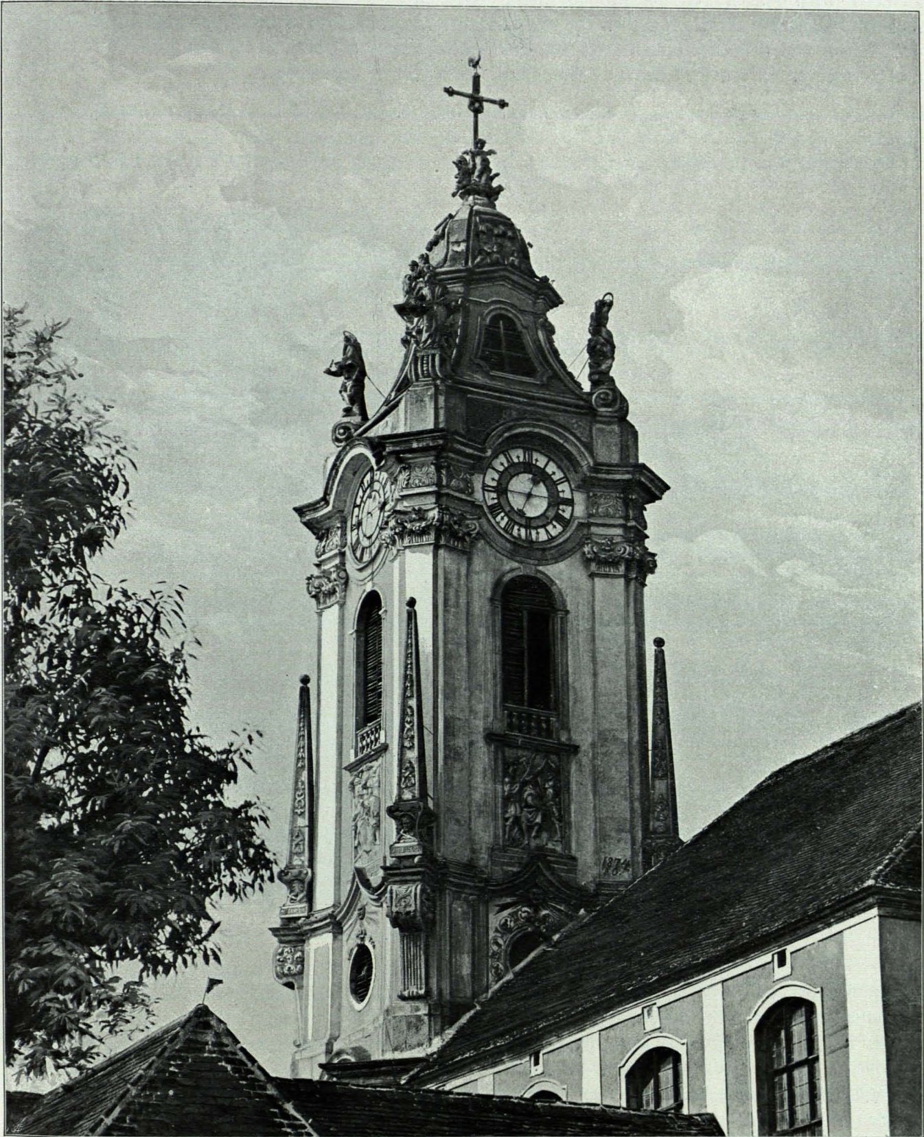
Fig. 24 Dürnstein, Pfarrkirche, Turm (S. 93)
