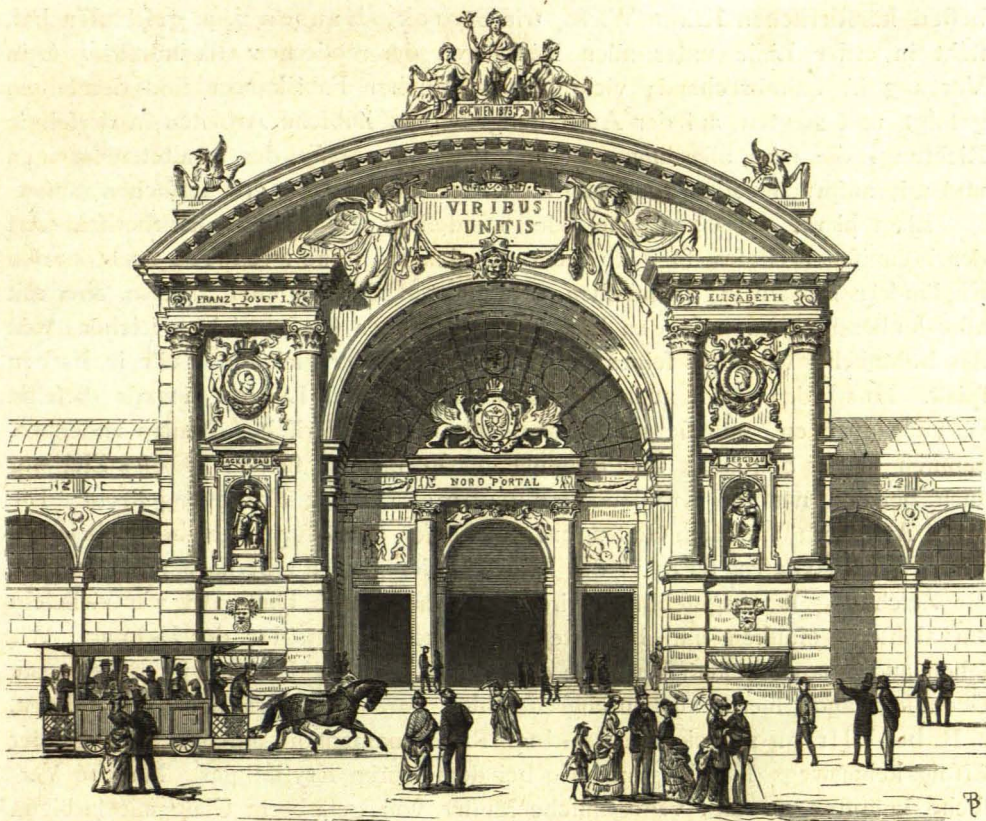
Nordportal der Industriehalle.
