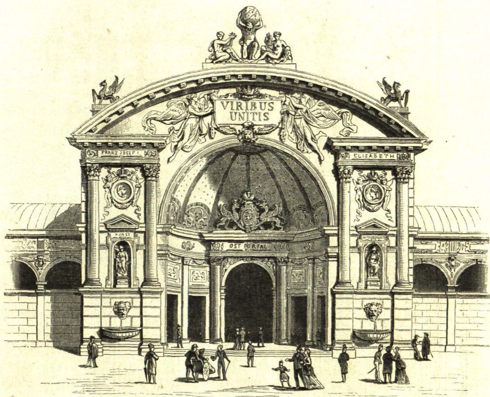
Ostportal der Induſtriahalle.
