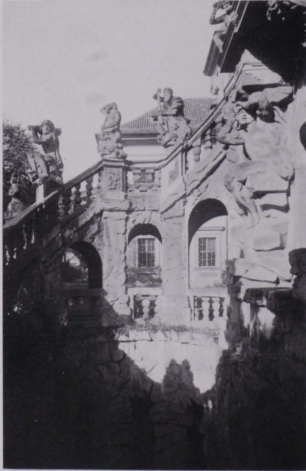
Abb. 15. Prag, Schloß Troja. Detail der Gartentreppe
