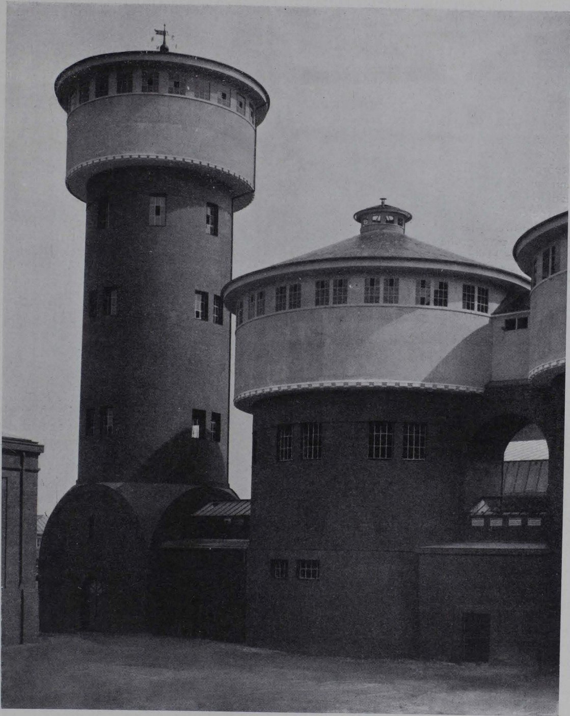
Abb. 201. Fabrikneubauten der Frankfurter Gasgesellschaft im Osthafen zu Frankfurt a. M. 1911 bis 1912. Wasserturm und Teerhochbehälter
