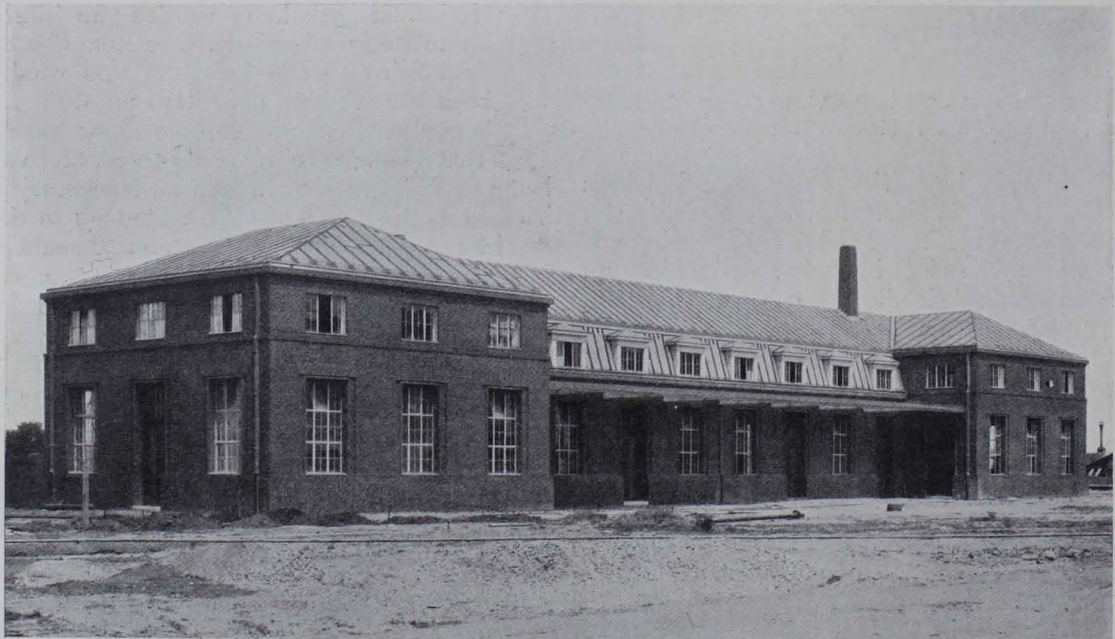
Abb. 200. Fabrikneubauten der Frankfurter Gasgesellschaft im Olfhafen zu Frankfurt a. M. 1911 bis 1912. Werkstättenbau
