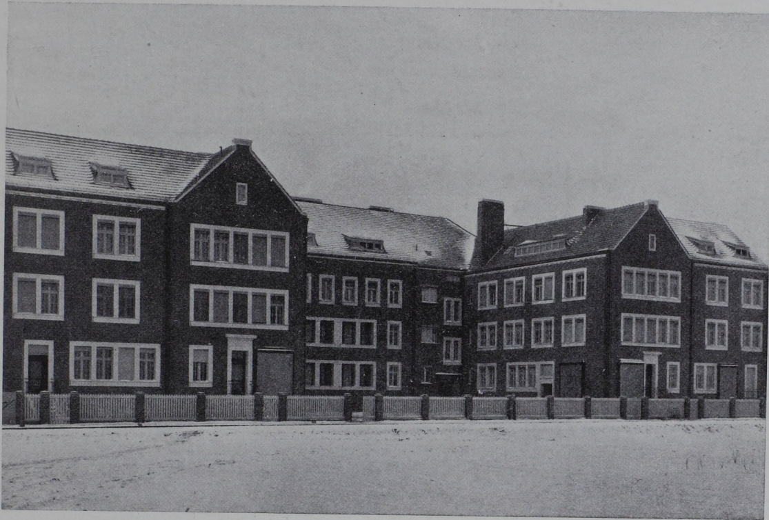
Abb. 174. Zinshäuser für Arbeiter der AEG in Hennigsdorf bei Berlin. 1910 bis 1911
