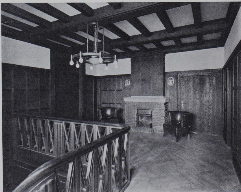
Abb. 179. Bootshaus «Elektra» der Angestellten der AEG in Ober Schöneweide bei Berlin. 1910. Treppendiele im ersten Obergeschoß
