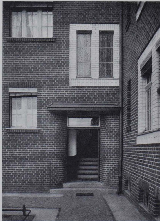
Abb. 173. Zinshäuser für Arbeiter der AEG in Hennigsdorf bei Berlin. 1910 bis 1911. Hofdetail
