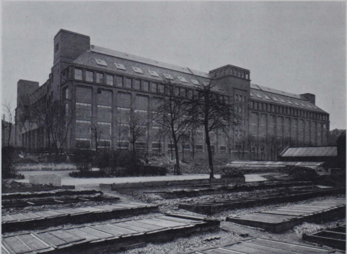
Abb. 157. Hochspannungsfabrik der AEG am Humboldthain in Berlin. 1910. Ansicht von Nordosten
