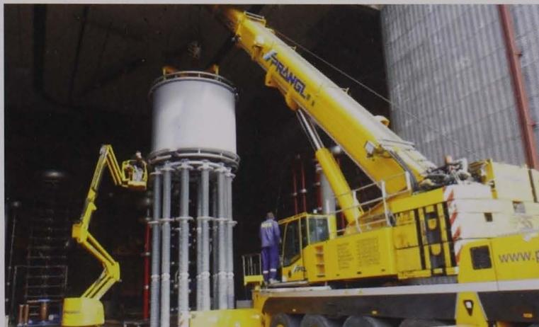
Montage einer  $\pm 533\text{kV}$  HGÜ Glättungsdrossel mit einem 100t Autokran im Höchstspannungslabor des Instituts (©IHS 2013)
