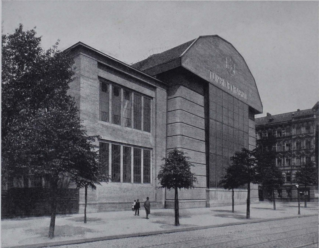
Abb. 124. Turbinenhalle der AEG, Ecke Hutten- und Berlichingenstraße, in Berlin-Moabit. 1909. Südwestansicht
