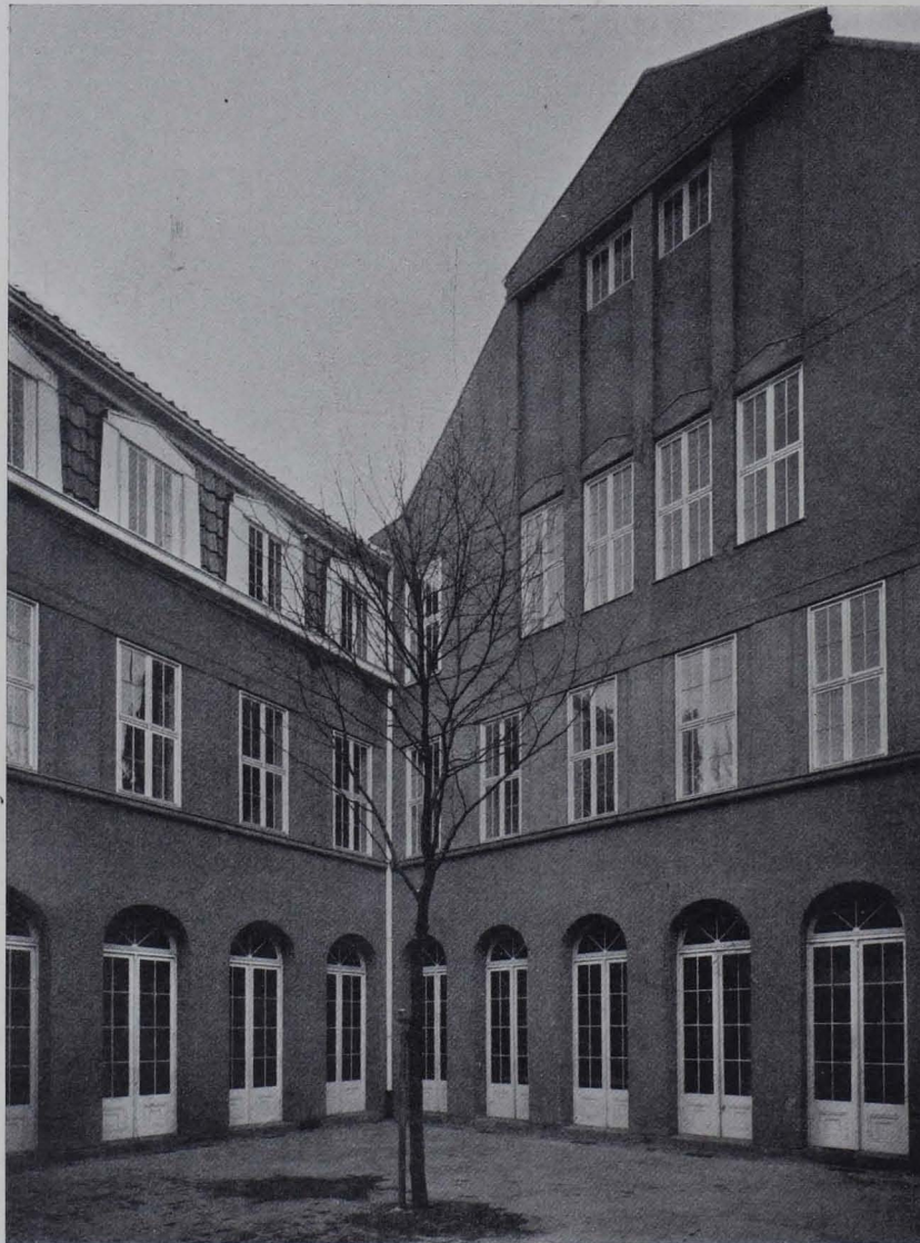
Abb. 104. Kathol. Gefellenhaus in Neuß a. Rh. 1908 bis 1910. Blick in die Nordwestecke des Arkadenhofs
