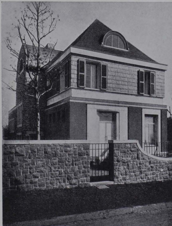
Abb. 92. Wohnhaus Schroeder in Eppenhäusen bei Hagen i. Westf. 1908 bis 1909. Seitenansicht von der Hassleyerstraße aus
