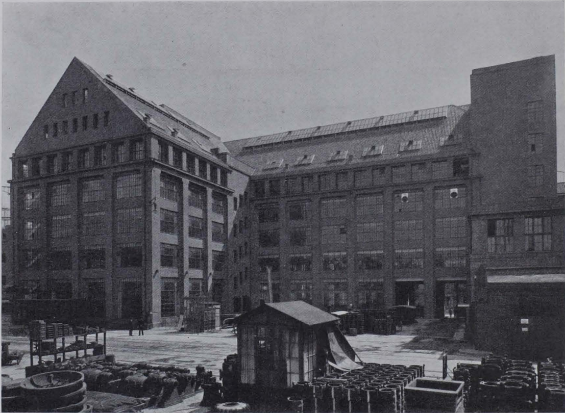
Abb. 163. Kleinmotorenfabrik der AEG an der Voltastraße in Berlin. 1910 bis 1911. Hofanficht
