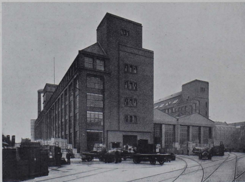
Abb. 155. Hochspannungsfabrik der AEG am Humboldtthain in Berlin. 1910. Anfsicht von Nordwesten
