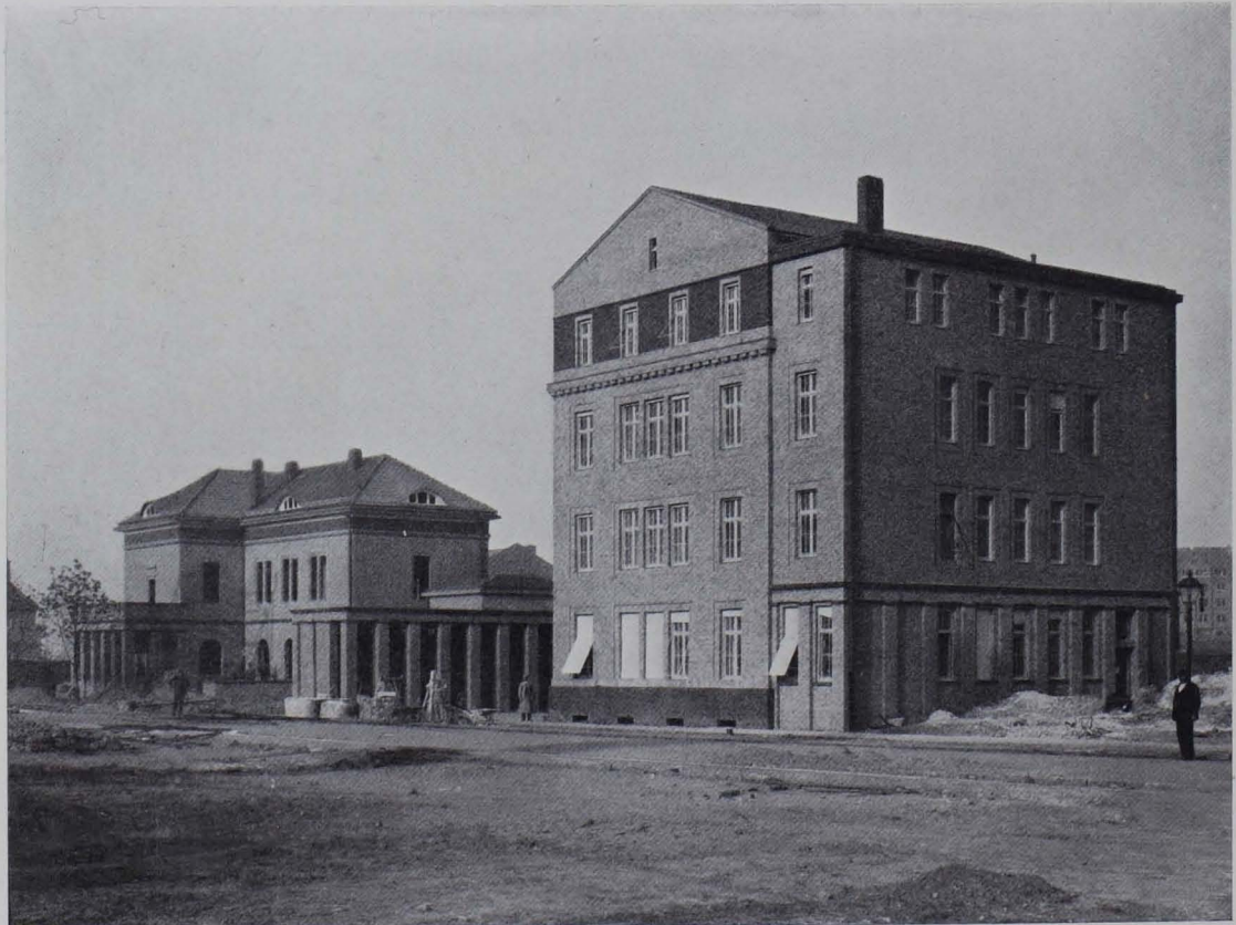
Abb. 197. Fabrikneubauten der Frankfurter Gasgesellschaft im Osthafen zu Frankfurt a. M. 1911 bis 1912. Wohnhaus des Betriebsleiters, Fabrikportal und Bureaugebäude vom Fabrikgebäude aus gesehen
