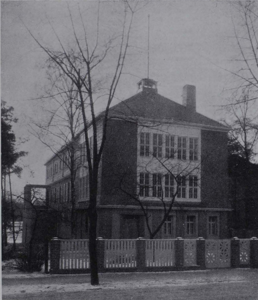
Abb. 178. Bootshaus «Elektra» der Angestellten der AEG in Oberschöneweide bei Berlin. 1910. Ansicht von der Straße
