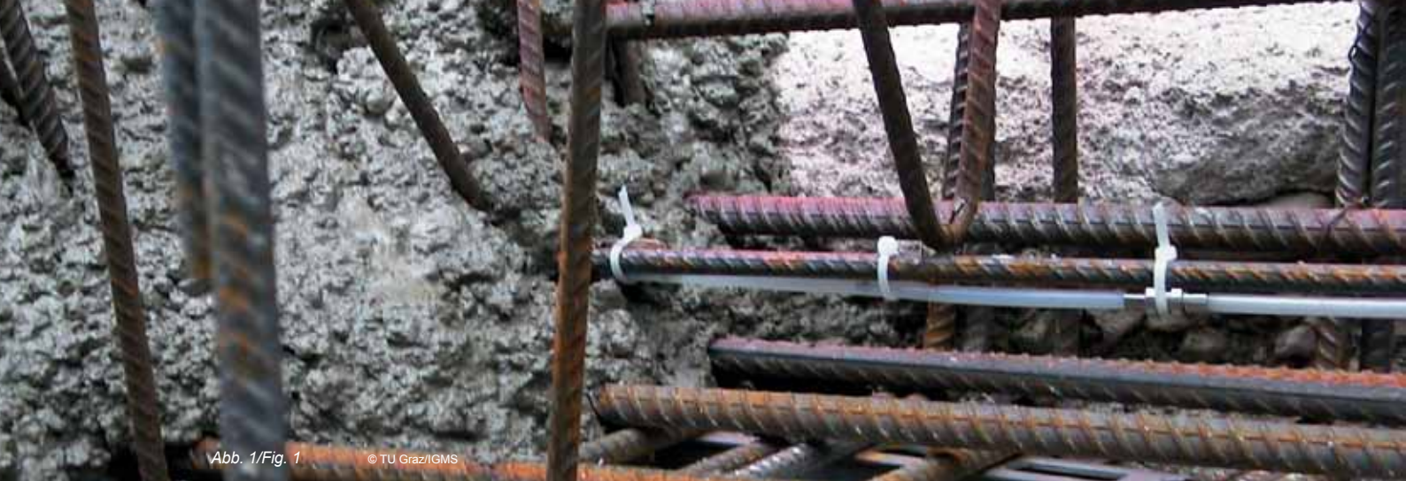
Abb. 1: Einbetonieren eines faseroptischen Sensors in ein Brückendeck.
