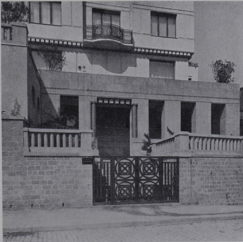
Abb. 38. Wohnhaus Gustav Obenauer in St. Johann-Saarbrücken 1905 bis 1906. Straßeneingang
