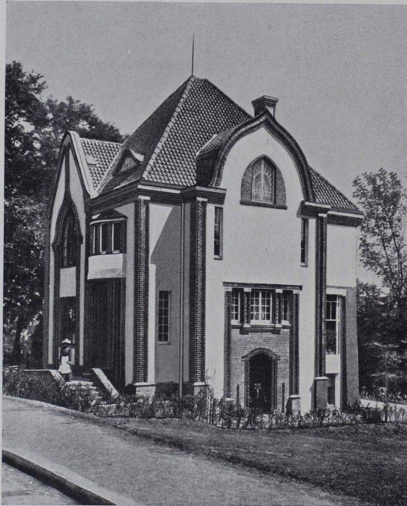
Abb. 6. Haus Behrens in Darmstadt. 1900/1901. Ansicht von der Straße aus
