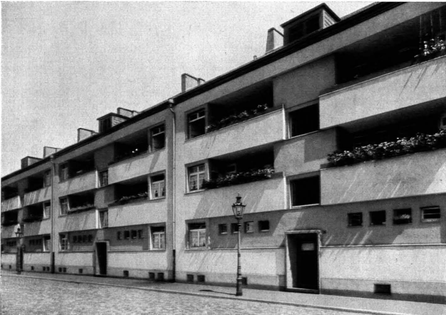
236. W. Riphahn u. Grod: Aus der Siedlung Bickendorf-Köln. 1925/26
