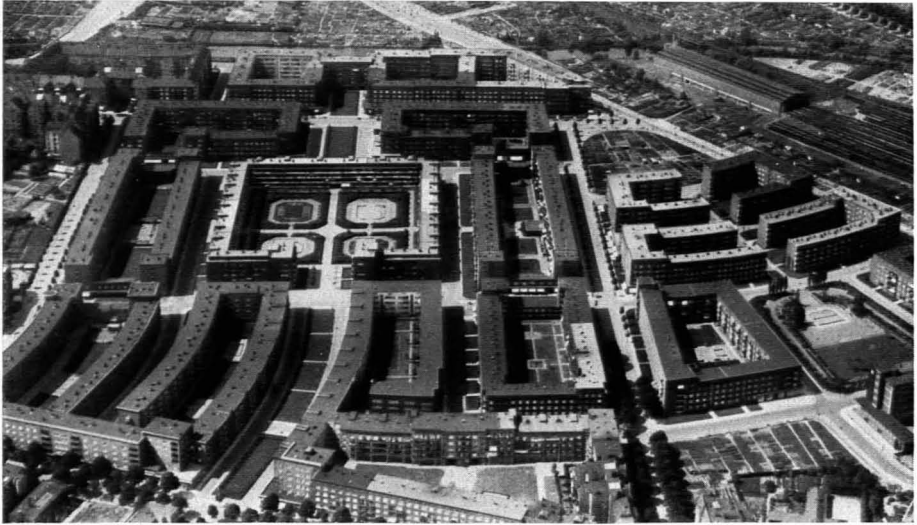
231. Beispiel eines Kleinwohnungsgebietes in Stockwerksbauten. Hamburg. 1929/30 Freigegeben durch RLM. Nr. 4864/35. Hersteller: Ingenieurwesen, Hamburg
