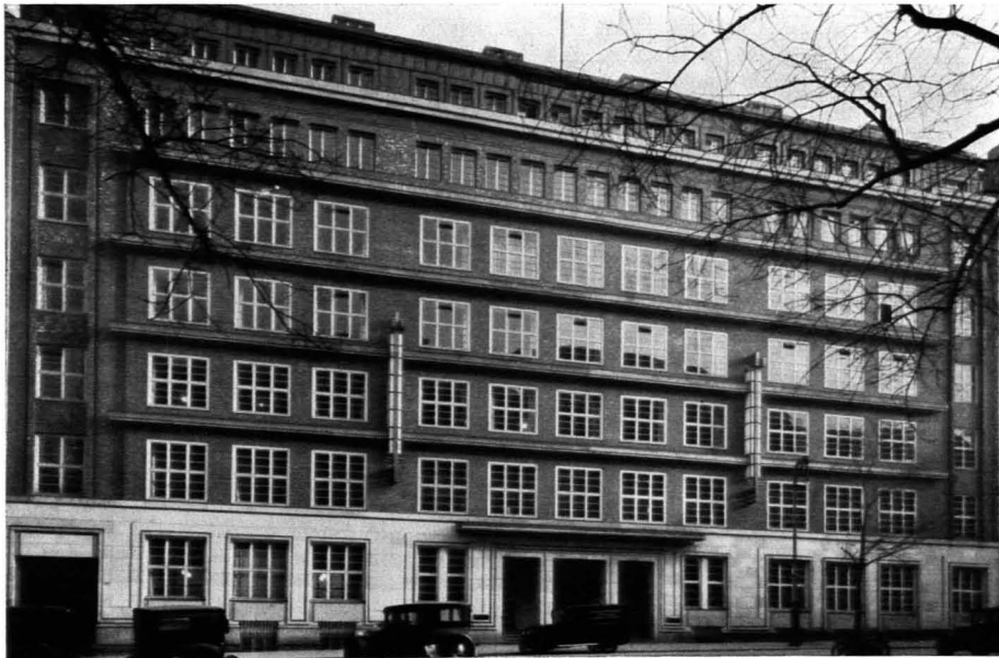
199. Hermann Distel: Verwaltungsgebäude der Hamburger Elektrizitätswerke. 1930
