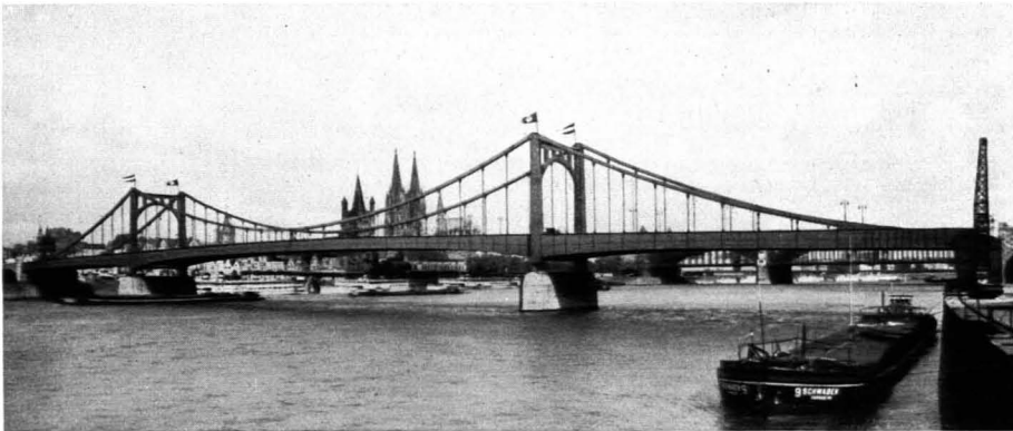
153. Werk Gustävsburg: Hängebrücke in Köln. (Arch. Moritz.) 1913/15
