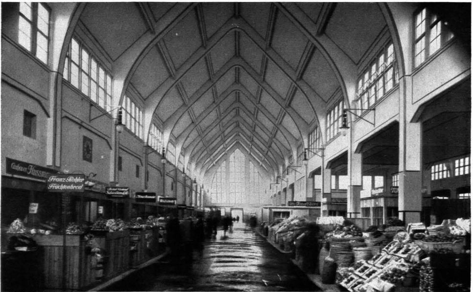
136. Richard Schachner: Großmarkthalle in München. 1911
